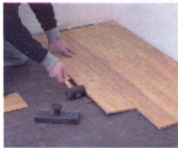
Sopra, il posizionamento di una pavimentazione a contatto con un materassino contenente fibre di carbonio per il riscaldamento.
