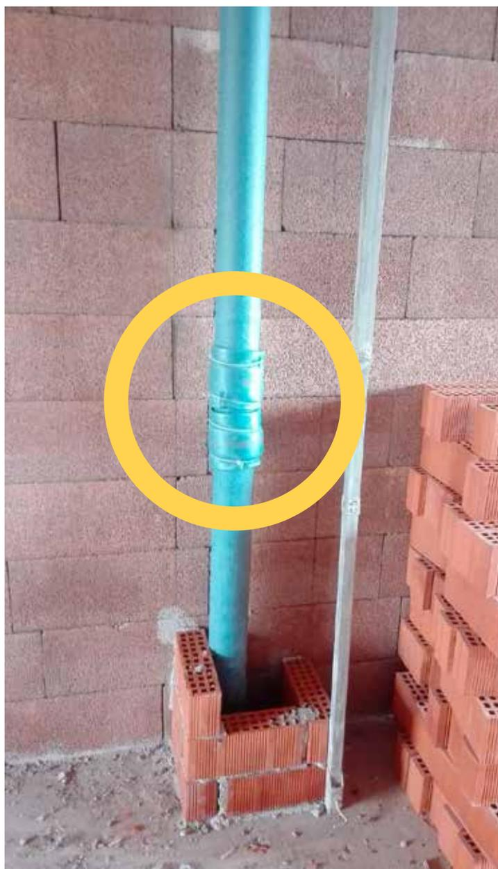
Unione tra i due isolanti acustici, fondamentale per il giusto isolamento, il nastro SONIK specifico fissato con due fascette.
