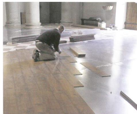
*In senso orario: l'opera di installazione della pedana riscaldante elettrica prodotta da Thermal Technology in uno spazio di culto e altri due esempi di interventi conclusi con la pedana collocata sotto i banchi.*
