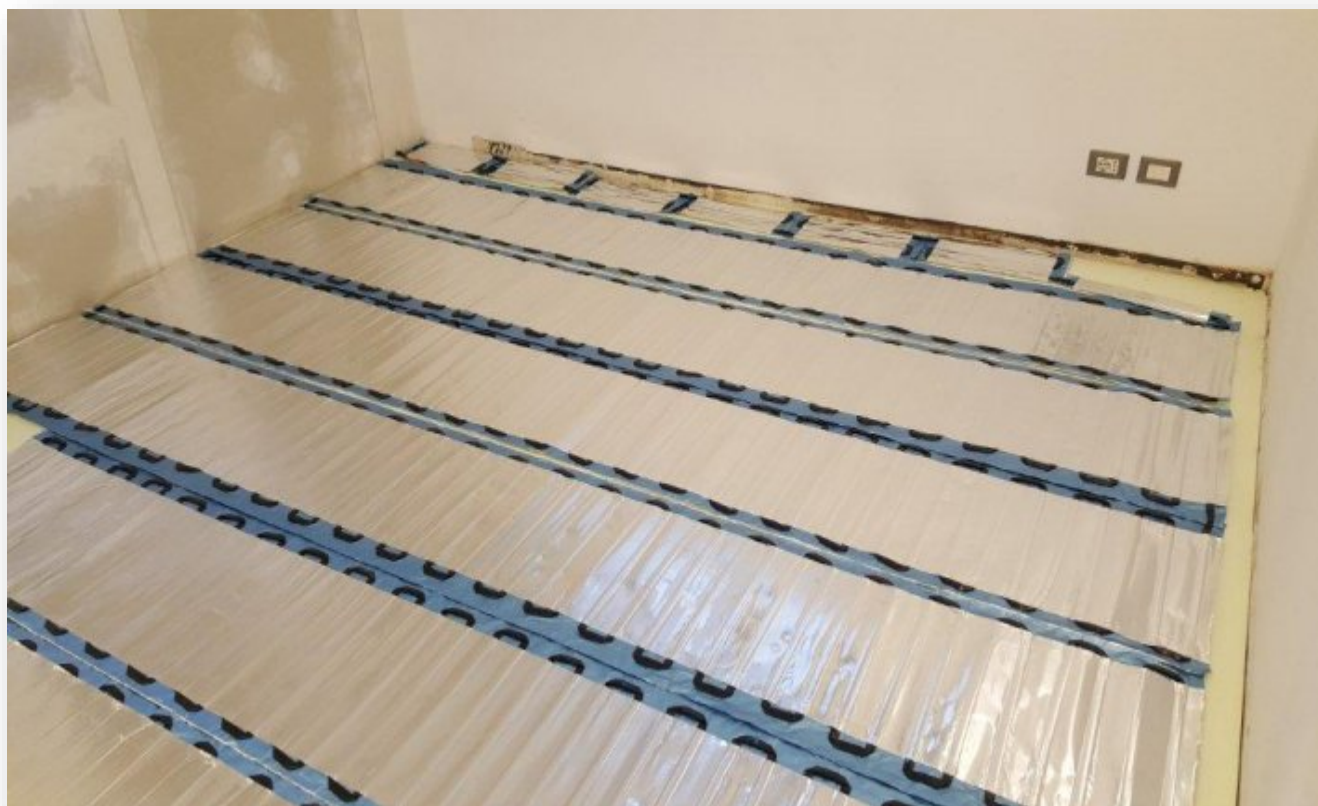
Abitazione privata: posa flottante
