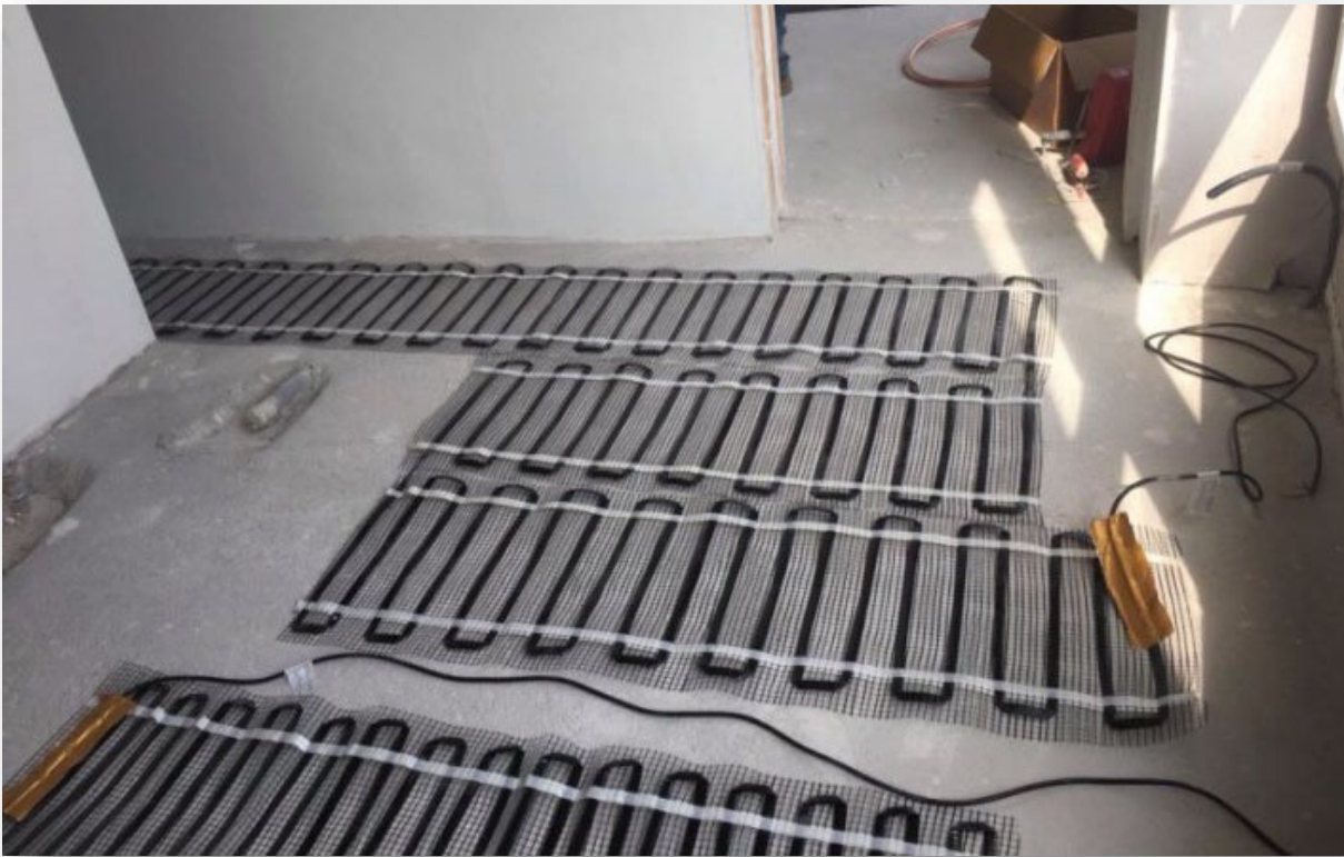
Abitazione privata: posa sottopiastrella
