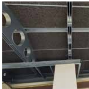
Soffitto realizzato con B-FLEX NR spelato
